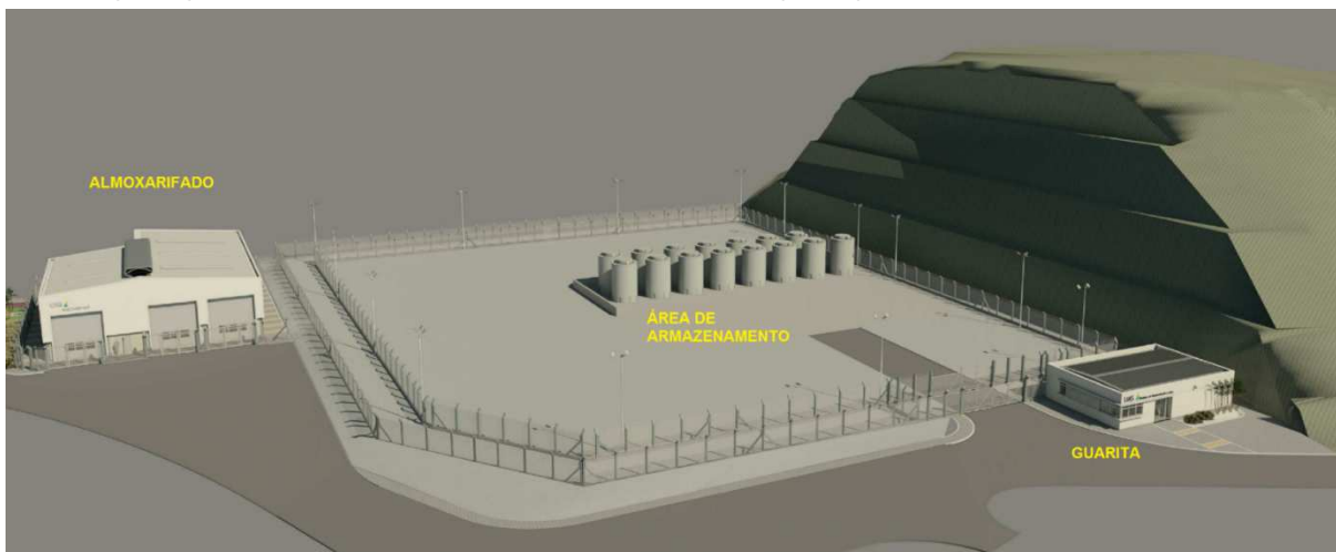
Figura 4-16 - Representação esquemática da Unidade de Armazenamento Complementar a Seco (UAS) de Elementos Combustíveis Irrradiados (ECIs)
